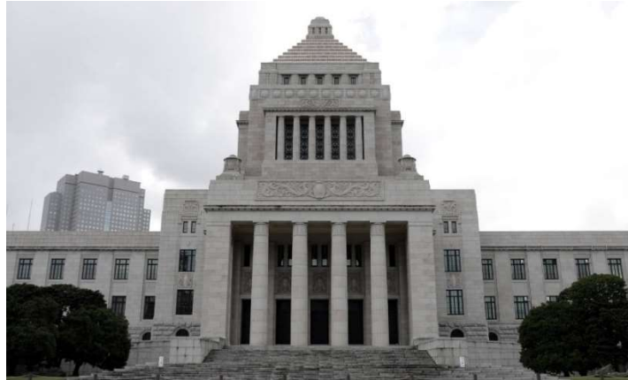
Fig. 388. Edificio de la Dieta, Tokyo, Japón.
