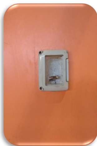
Figura 4.14. Solución para empotrar los ganchos dentro de carcasa protectora.
