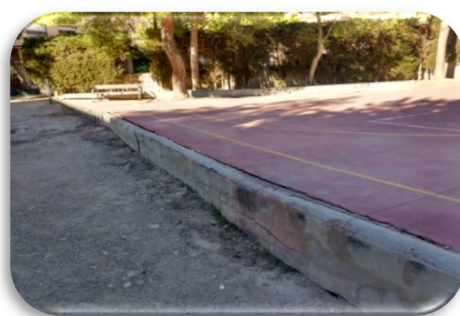
Figura 4.13. Bordillo en altura en los límites de la pista deportiva.
