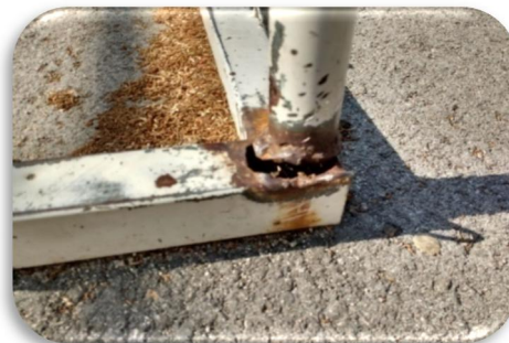
Figura 4.31. Portería con signos de rotura.
