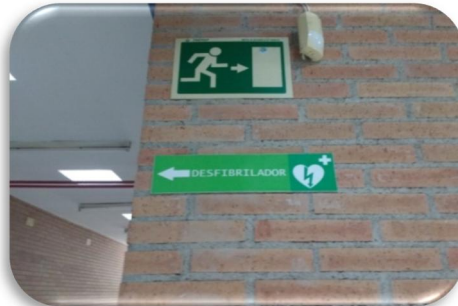
Figura 4.16. Señalización de los recorridos de evacuación.
