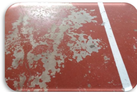
Figura 4.12. Pavimento rígido en espacio deportivo cubierto.
