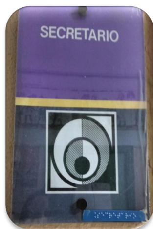
Figura 4.5. Señalización de espacio con pictograma y Braille.
