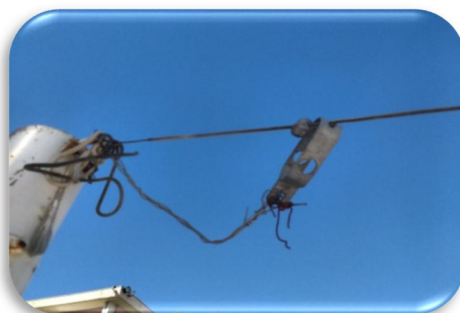
Figura 4.36. Cable de tensado en mal estado.
